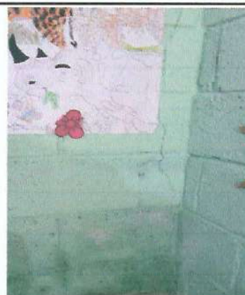
Foto 4: Reparación de repello y cernido de paredes.
