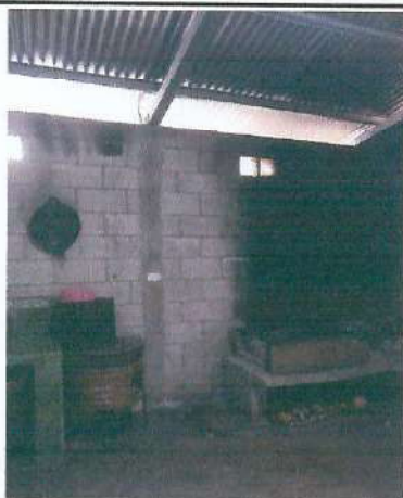
Foto 1: Mejoramiento de área de cocina
