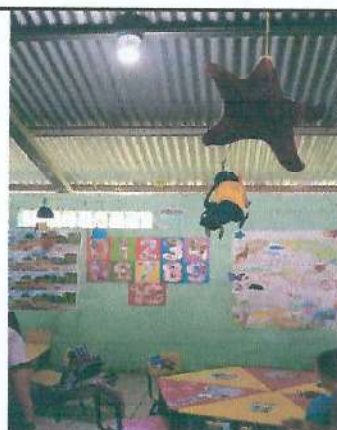
Foto 3: Reparación de repello y cernido de paredes.
