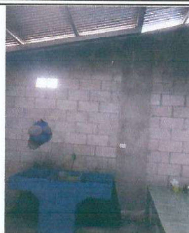
Foto 2: Reparación de sistema eléctrico.
